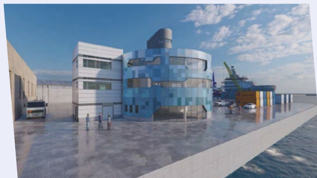
PortCastelló refuerza la seguridad con la adecuación de su centro de control
