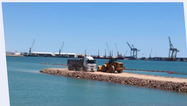
PortCastelló arranca el proyecto de expansión en su dársena sur con el inicio de las obras de la mota de cierre
