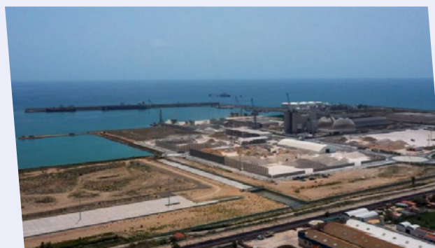
Licitación de la obra de dos nuevos pasos viarios sobre el canal de drenaje
