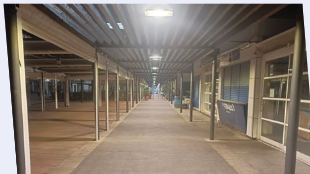
Instalación de nuevas luminarias en el moll de costa
