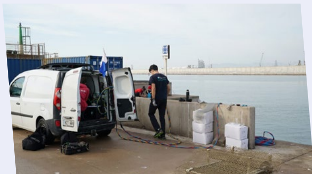
PortCastelló apuesta por la regeneración marina con la instalación de estructuras para renaturalizar el área portuaria
