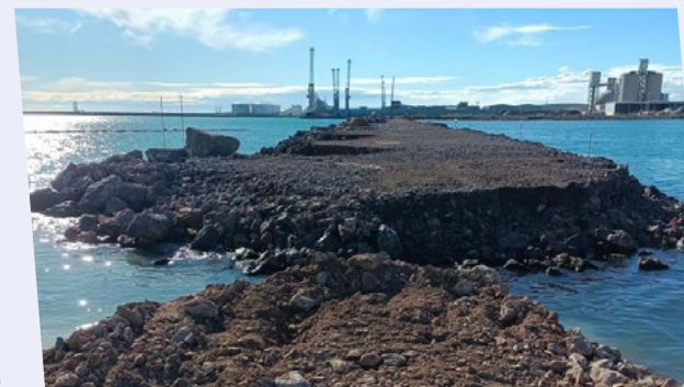
Finalización de la obra de la mota de cierre
