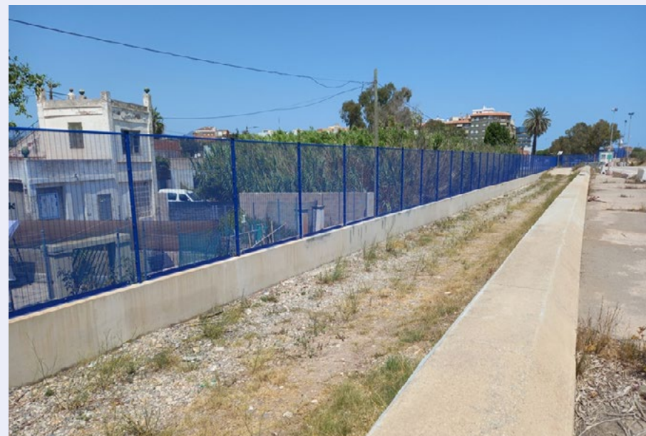
Acondicionamiento del vallado de la Dársena Sur ejecutado
